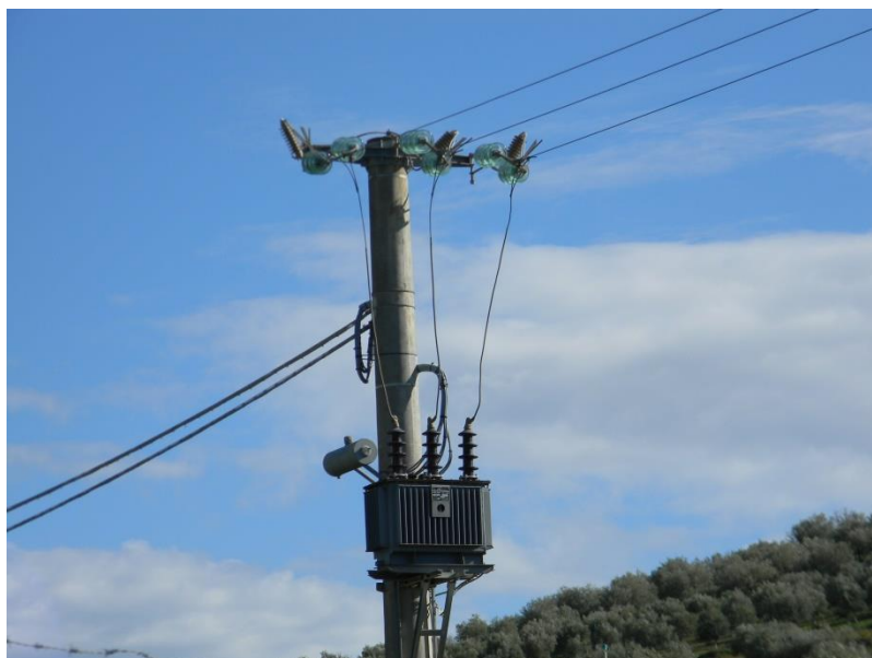
Figura 22 Esempio di trasformatore di media tensione posto su un palo di sostegno della linea elettrica. Un modello simile potrebbe essere la sorgente dei segnali RFI misurati nella banda del ricevitore P ed L.
