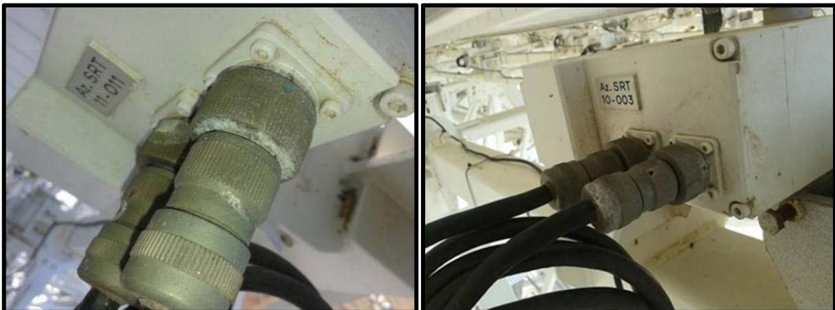
Per questa tipologia di connettori elettrici nella versione standard utilizzata, il corpo è costruito in lega di alluminio e subisce un trattamento superficiale di cromatazione e passivazione che conferisce al connettore una colorazione verde oliva. La cromatazione, forma uno strato con un'ottima resistenza alla corrosione che generalmente è sufficiente a garantire lunghi periodi di esposizione in esterno senza che appaia evidenza di ossidazione.
