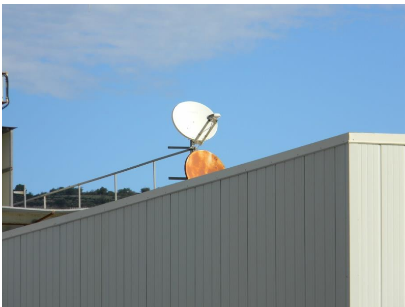
Figura 32 Sistema di ricezione della TV satellitare installato sul tetto della stazione radio astronomica di Noto. Alcuni rilievi nella banda 18-40 GHz evidenziano che un mal funzionamento dell'oscillatore locale dell'illuminatore della parabola alla frequenza 9750 MHz genera una forte emissione alle frequenze 29.25 GHz e 39.01 GHz rispettivamente terza e quarta armonica della frequenza fondamentale 9750 MHz.
