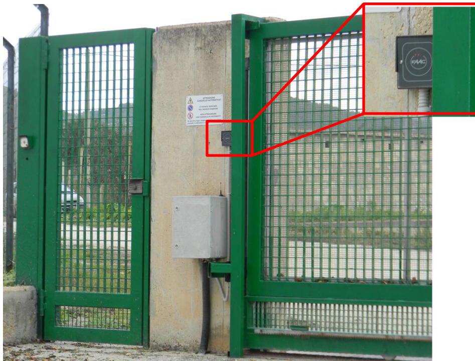
Figura 27 Cancelli di ingresso della stazione radio astronomica di Noto. Nel dettaglio cerchiato di rosso è mostrato il sistema di apertura automatica che da origine ai segnali RFI in banda P mostrati in Figura 28.
